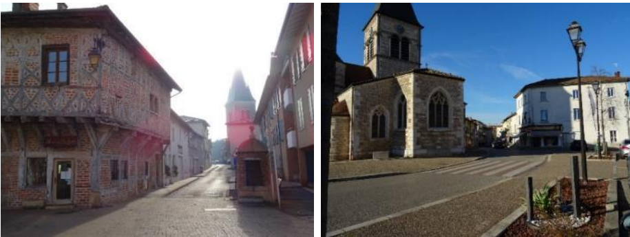
Centre bourg, four et maison à colombages, St Trivier sur Moignans – Centre bourg, Villars les Dombes
