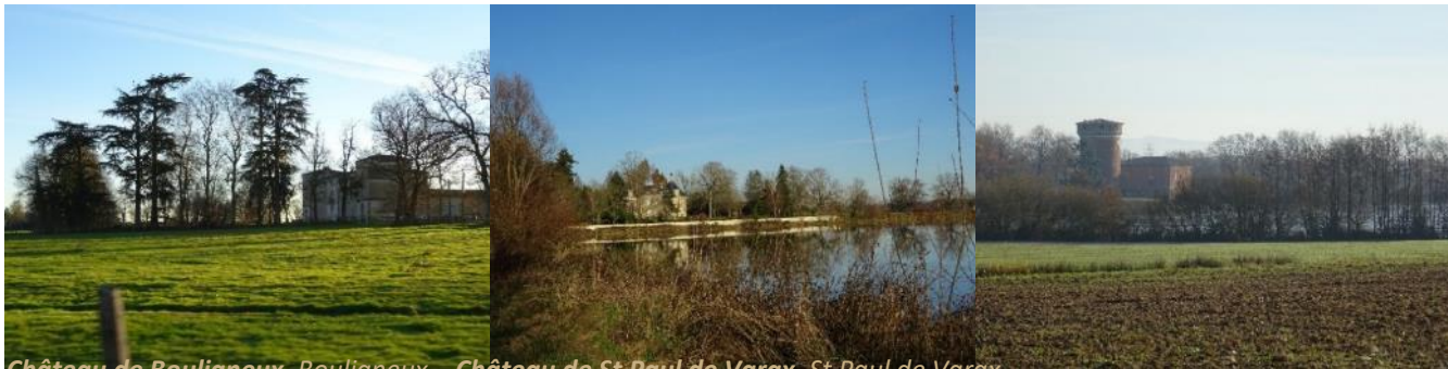
Château de Bouligneux, Bouligneux – Château de St Paul de Varax, St Paul de Varax
