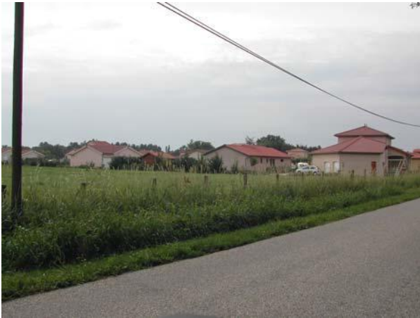
Entrée du Birieux
