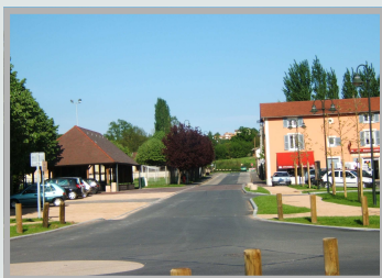
Sécurisation de la traversée de Frans
